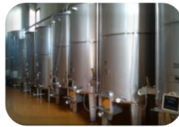
Dosificación en reactores, tanques y tolvas
